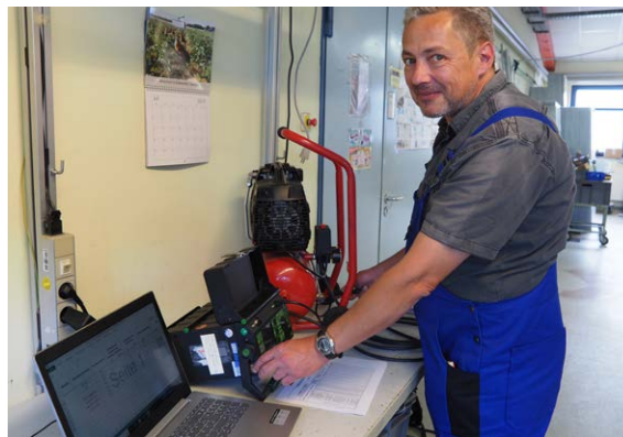
Matthias Wilhelm prüft an einem Kompressor in den GWE die elektrischen Widerstände mit dem speziellen Messgerät.
