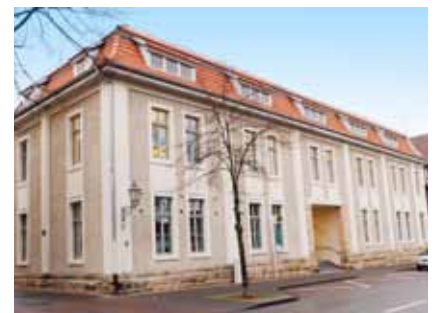
Die Fassade des Klages-Gebäudes leuchtet nach der Sanierung im hellen Neuanstrich.
